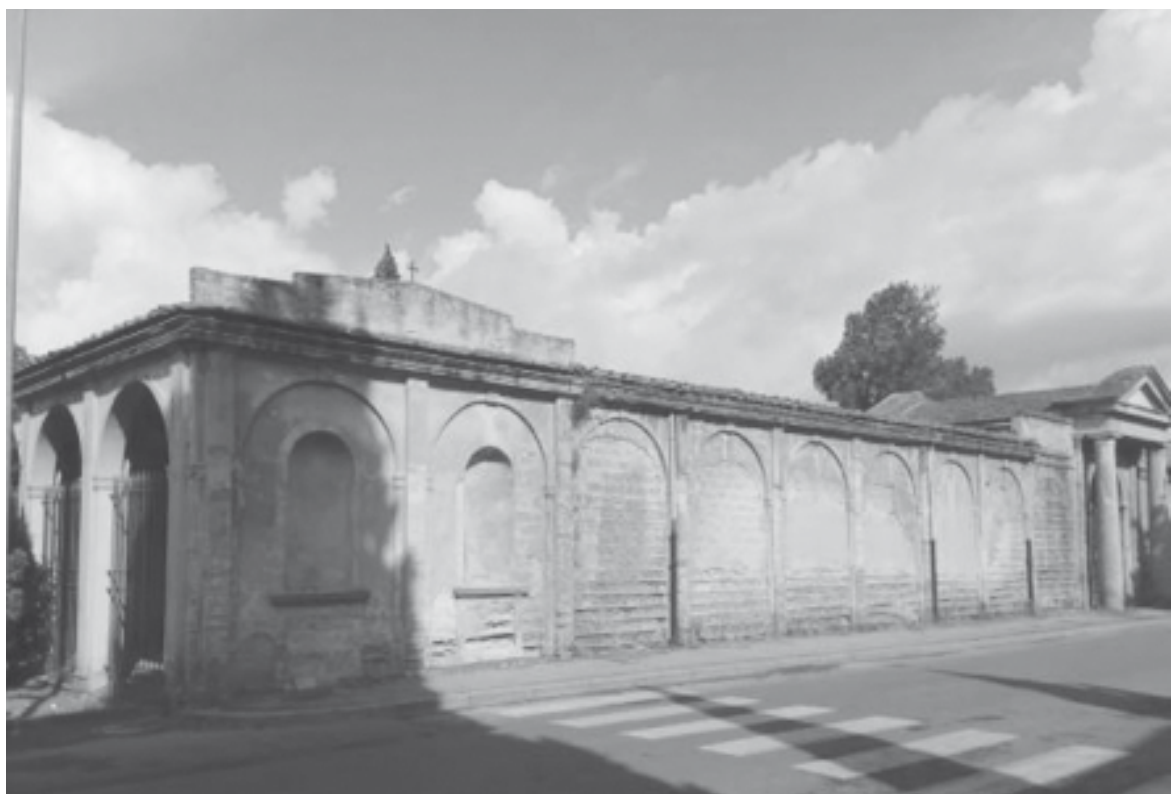
Il progetto di recupero, del costo complessivo di 300.000 euro, è finanziato dalle casse del Comune
